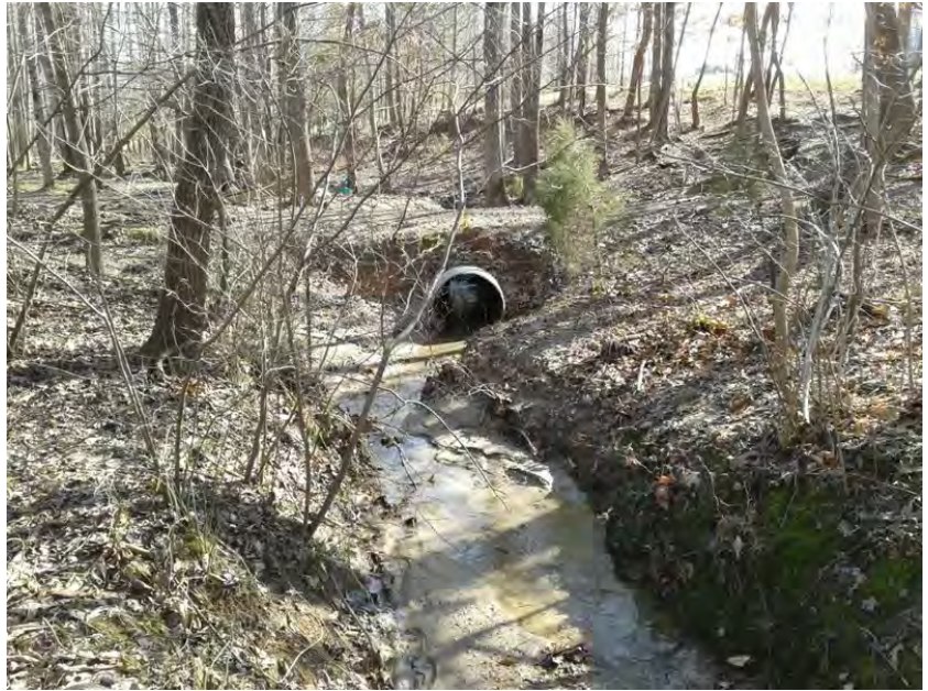
A19 ext, downstream, SE
